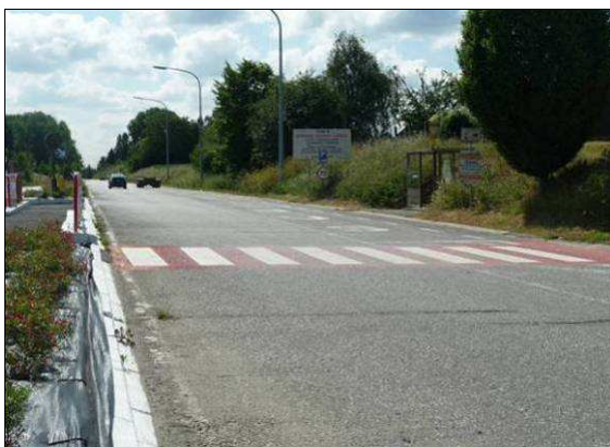
Figure 547 : Photographie d'une traversée piétonne avec revêtement de couleur différente, route Industrielle, à Wisbecq
