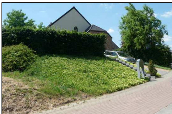
Figure 545 : Photographie d'un trottoir de qualité, rue des Cendres, à Rebecq
