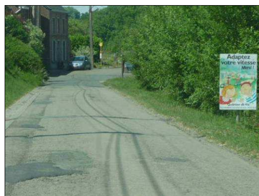
Figure 523 : Photographie d'une signalisation d'un quartier de vie, rue Haute Franchise, à Rebecq
