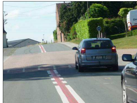
Figure 583 : Photographie d'un plateau avec changement de revêtement, drève de la Chevalerie, à Bierghes
