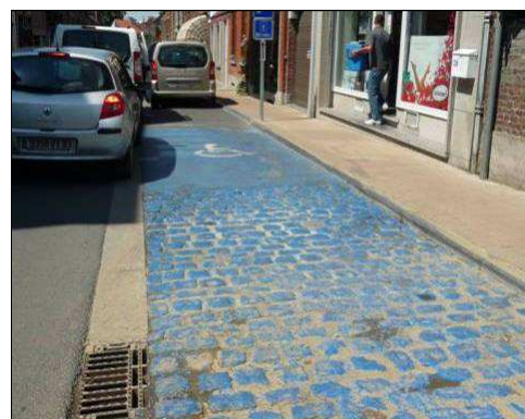
Figure 558 : Photographie de places de stationnement réservées aux PMR, rue du Pont, dans le centre de Rebecq
