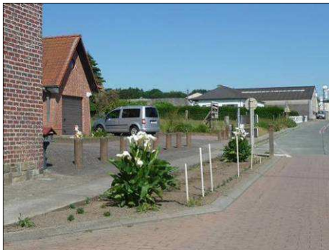
Figure 582 : Photographie d'une chicane rétrécissant la voirie, rue du Radoux, à Bierghes
