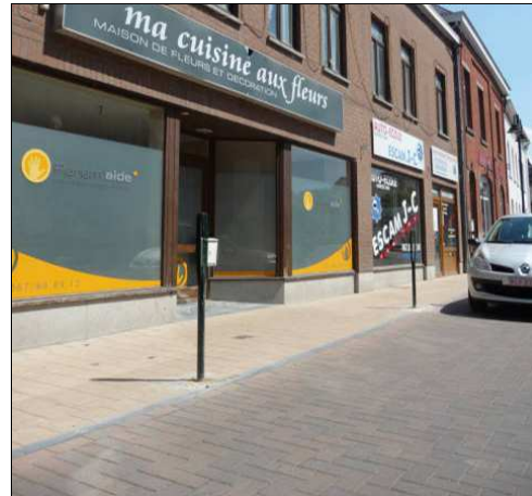
Figure 551 : Photographie d'une voirie de plain-pied, rue du Docteur Colson, à Rebecq
