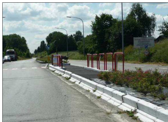
Figure 548 : Photographie d'une traversée piétonne en deux temps avec un îlot central, route Industrielle, à Wisbecq
