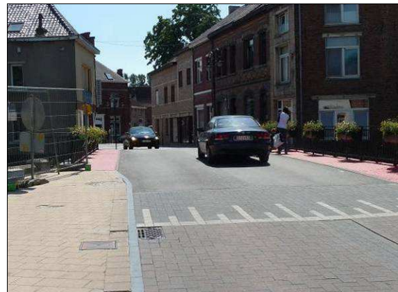
Figure 553 : Photographie de plusieurs types de revêtements, plateau, rue du Pont, à Rebecq
