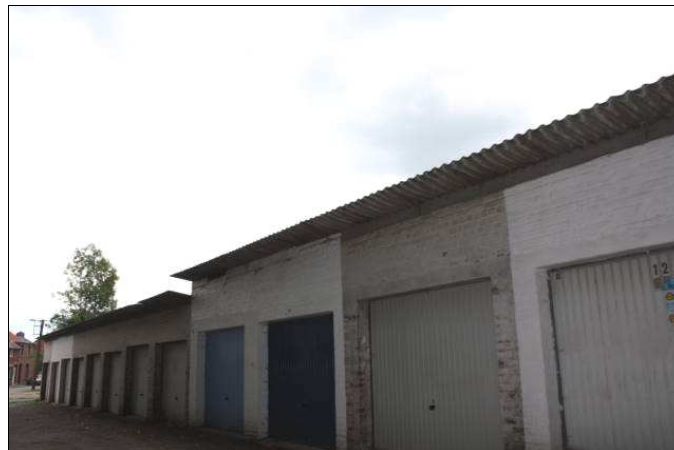
Figure 507 : Photographie de garages individuels – Vieux Chemin de Mons, zone résidentielle située entre le N6 et la carrière, à Quenast
