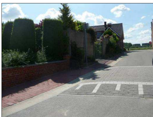
Figure 522 : Photographie d'un casse-vitesse signalé par un marquage et un changement de revêtement, rue Anne-Croix, à Bierghes
