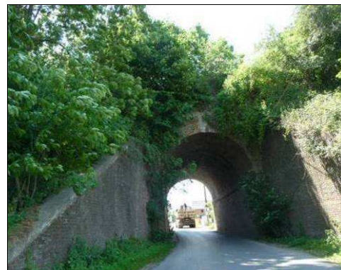
Figure 561 : Photographie d'un passage sous l'ancienne voie ferrée L115, chemin de Rebecq
