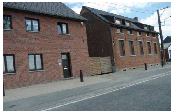
Figure 513 : Photographie de la rue Maieur Habils, N7, à Bierghes
