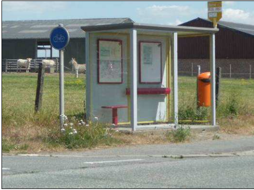
Figure 573 : Photographie d'un arrêt de bus aménagé sur la chaussée Maïeur Habils, N7, à Bierghes
