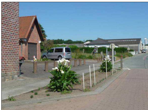
Figure 520 : Photographie d'une chicane, rue du Radoux, à Bierghes
