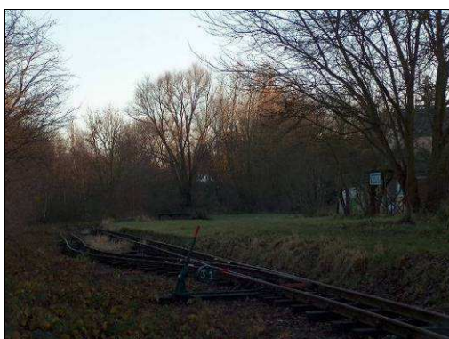
Figure 562 : Photographie de l'ancienne voie ferrée, L123
