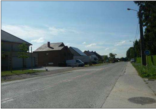
Figure 468 : Photographie de la rue du Radoux à l'extrême nord de la commune – hameau du Radoux
