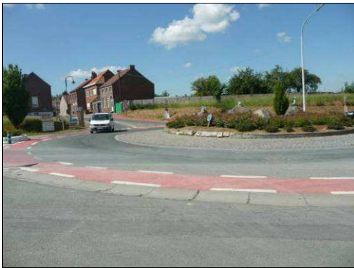
Figure 535 : Photographie d'une délimitation d'une piste cyclable sur le rond-point où débouchent la route Industrielle et la rue Sainte-Renelde, au niveau de l'échangeur de l'A8, Wisbecq
