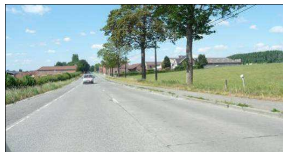
Figure 462 : Photographie de la N7 en direction d'Ath, avant l'entrée dans le centre de Bierghes
