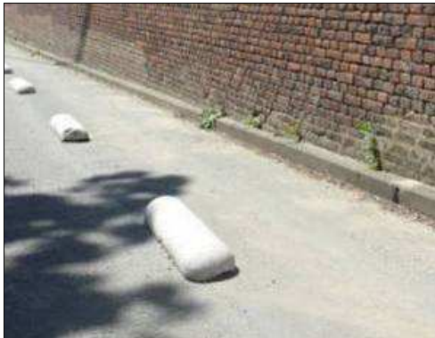
Figure 531 : Photographie d'un séparateur de trafic, système en demi-lune, rue de la Cure, à Rebecq
