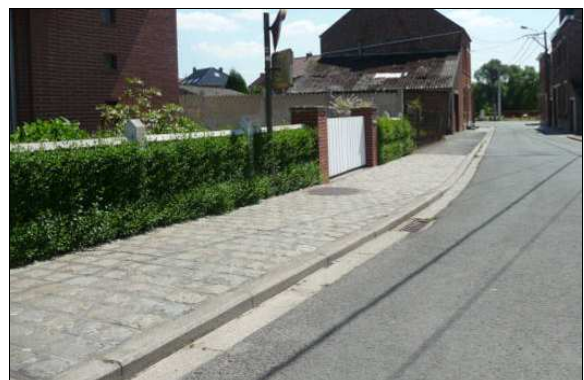
Figure 546 : Photographie d'un trottoir de qualité, chemin Froidmont, à Rebecq
