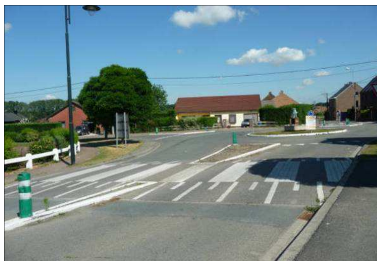
Figure 549 : Photographie d'un passage piéton avec plateau, changement de revêtement et petit îlot central, rue Caporal Trésignies, à Bierghes
