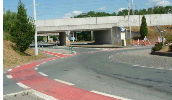
Figure 458 : Photographie de l'échangeur 24 depuis la rue Sainte-Renelde
