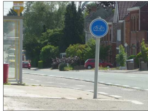
Figure 536 : Photographie d'une délimitation d'une piste cyclable avec panneau de signalisation et marquage au sol, chaussée Maïeur Habils, N7, Bierghes
