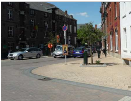
Figure 516 : Photographie de l'espace public sans différenciation de niveau entre la voirie et le trottoir, au centre de Rebecq
