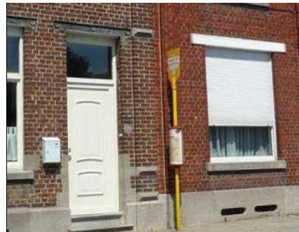
Figure 570 : Photographie d'un arrêt TEC, rue Trieu du Bois, à Rebecq
