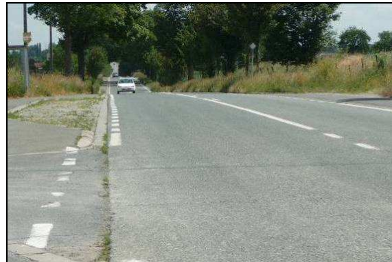
Figure 464 : Photographie de la N7 en direction d'Hal, après le croisement avec la rue du Boussart
