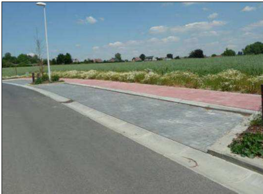
Figure 487 : Photographie de stationnement délimité sur le chemin Ardoirière, à Rebecq
